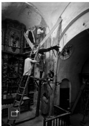
Trabajos de arranque de las pinturas murales de la iglesia de Santa Maria de Taüll, en 1922. / ARXIU MAS / INSTITUT AMATLLER
